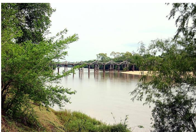
Obr. 22: Krátce před San Alfredo: starý most přes Rio Aquidaban. Jízda po dřevěném mostě byla vždy zážitkem.
